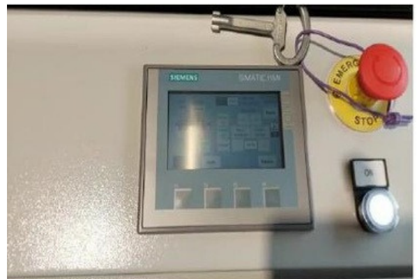
Steuerungsdisplay, Starttaste und Notausschalter
